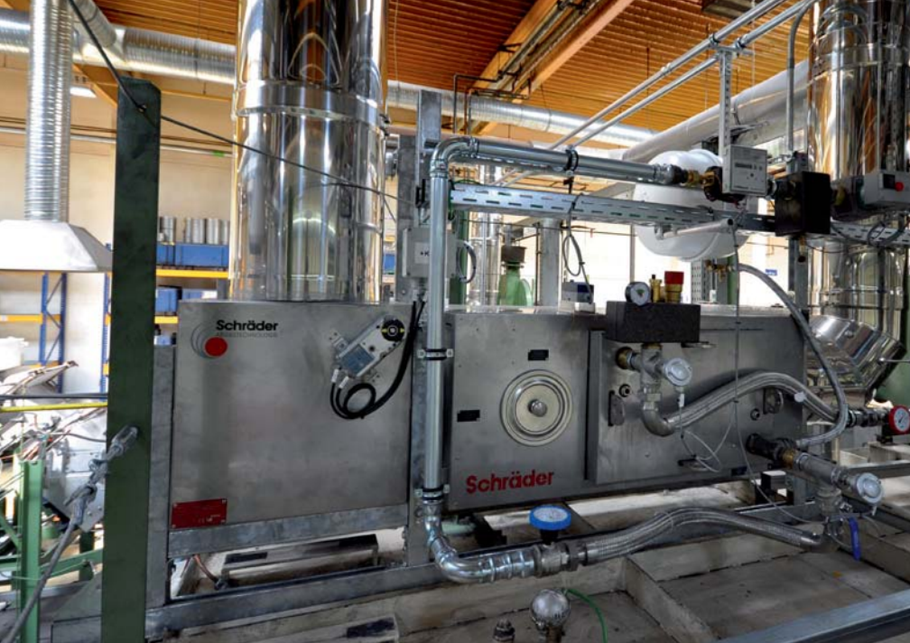
Der Abgaswärmetauscher von Schröder im Einsatz.
